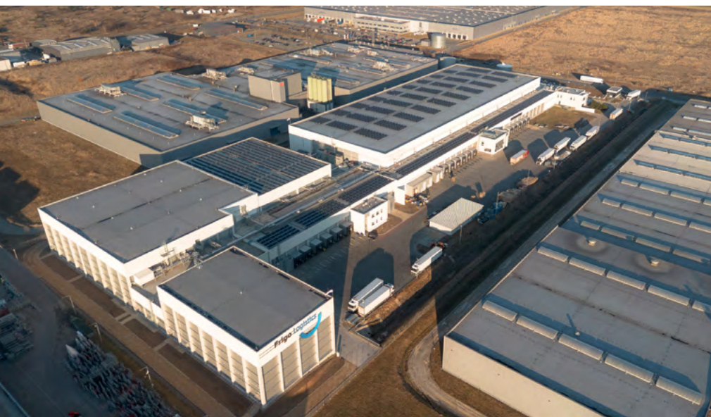
Po rozbudowie centrum dystrybucyjne Frigo Logistics w Radomsku dysponuje 40 000 miejsc paletowych.
